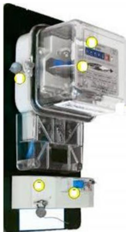
Gambar 3.12. Bentuk Fisik kWh Analog
